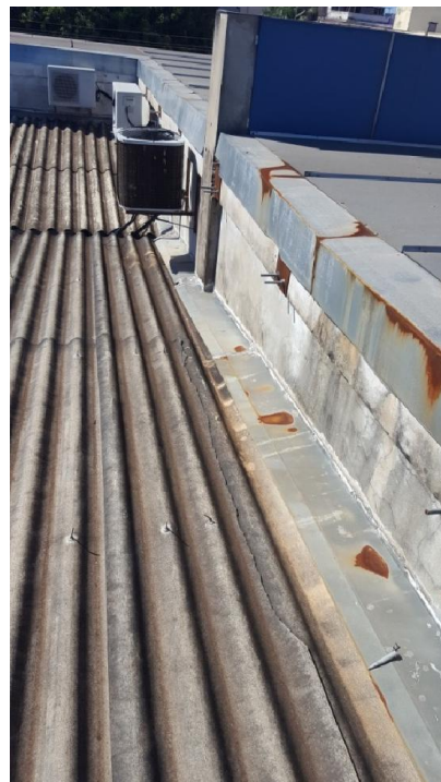
Foto 18 (Face superior do ACM da Fachada) e foto 19 (Cobertura) – Infiltrações e deformações das placas. Solução: Troca das placas danificadas e vedação das placas soltas.
