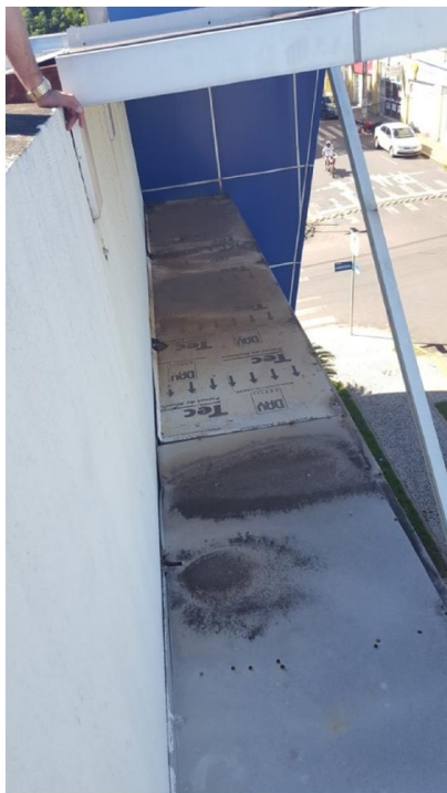
Foto 18 (Face superior do ACM da Fachada) e foto 19 (Cobertura) – Infiltrações e deformações das placas. Solução: Troca das placas danificadas e vedação das placas soltas.
